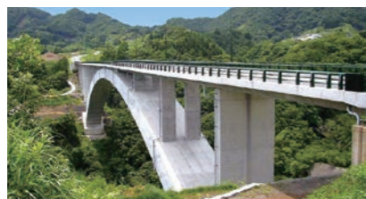
宮崎県国見大橋
