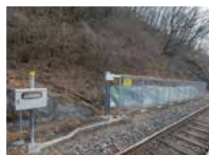
落石検知装置/ 土砂崩壊検知装置
