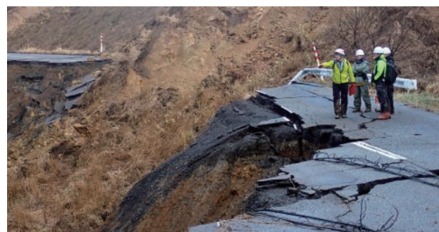
国道249号の調査中の様子
