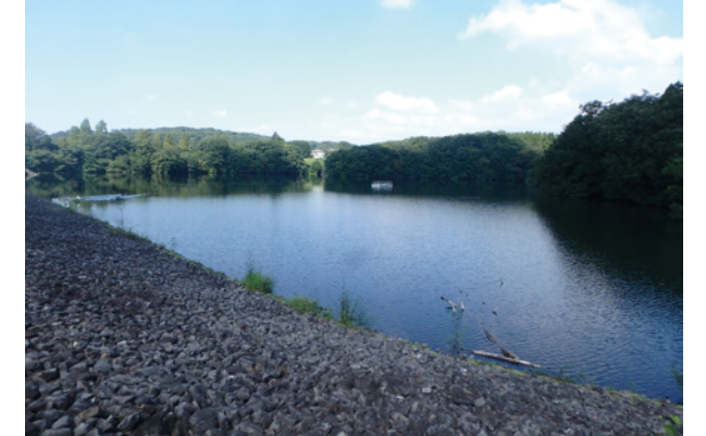
老朽化したため池改修
