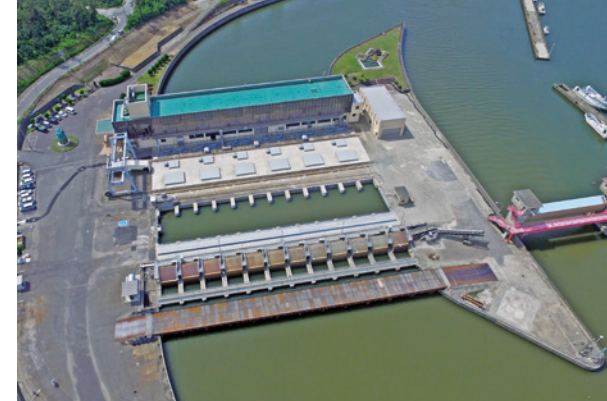
新川河口排水機場
