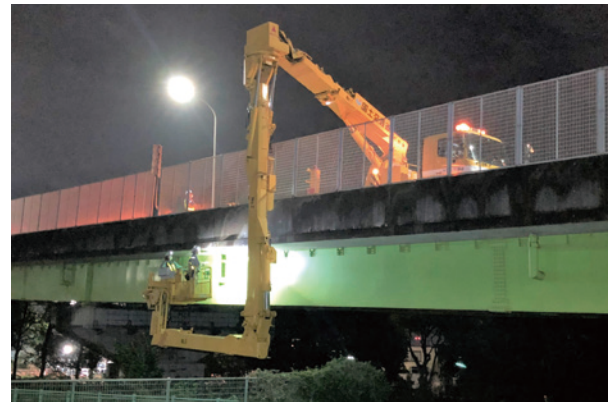
R3国道298号北首都圏道管内橋梁点検業務
