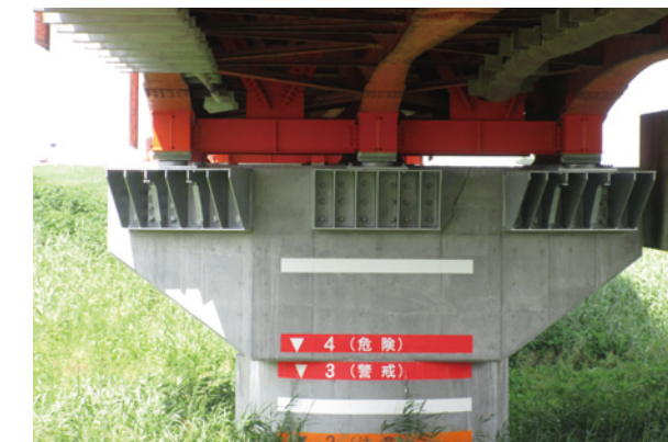
長豊橋下部工
