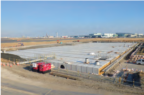
東京国際空港地下式貯留施設
