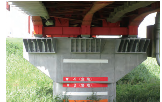
長豊橋下部工
