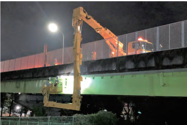
R3国道298号北首都道管内橋梁点検業務
