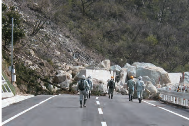
国道364号大内道路
