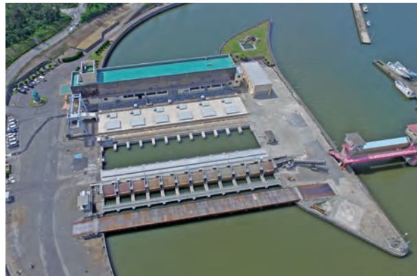
新川河口排水機場
