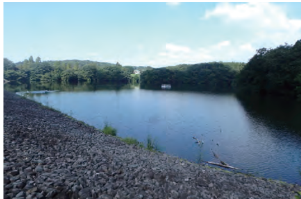
老朽化したため池改修
