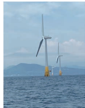
五島市沖 浮体式洋上風力発電
