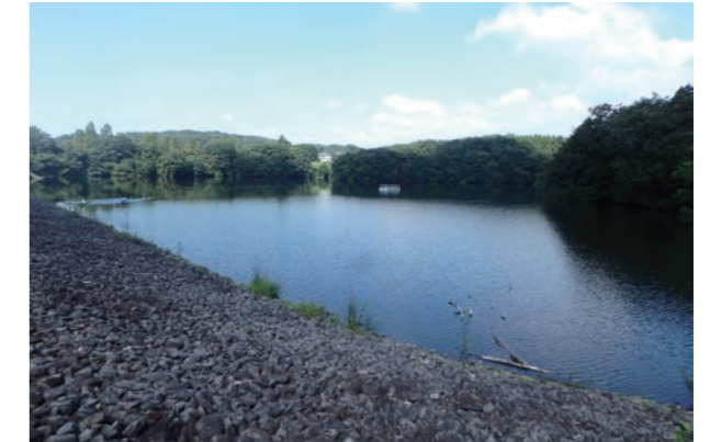
老朽化したため池改修
