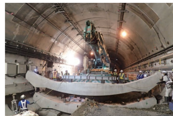
国道289号甲子トンネル
