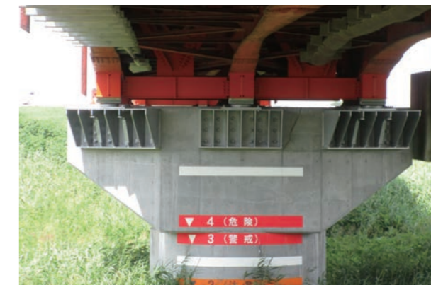
長豊橋下部工
