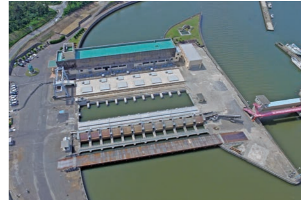
新川河口排水機場
