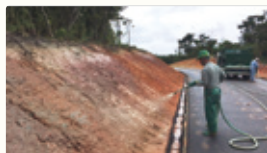
造成法面への散布の様子
