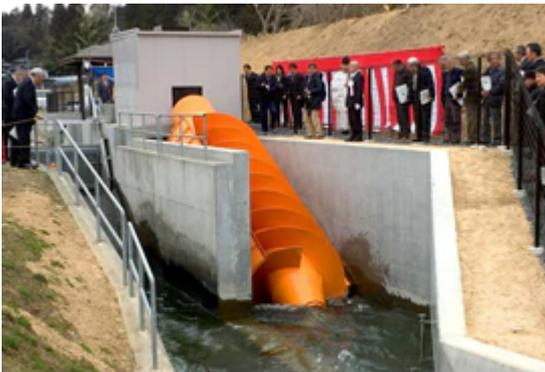
同社が自社開発・製造した、国産初のらせん水車。八幡沢発電所（岩手県一関市）で2019年4月に運転開始。らせん水車は低落差で発電でき、枯葉などのゴミが詰まりにくい特長があるため、農業用水路を活用した小水力発電に適している。
