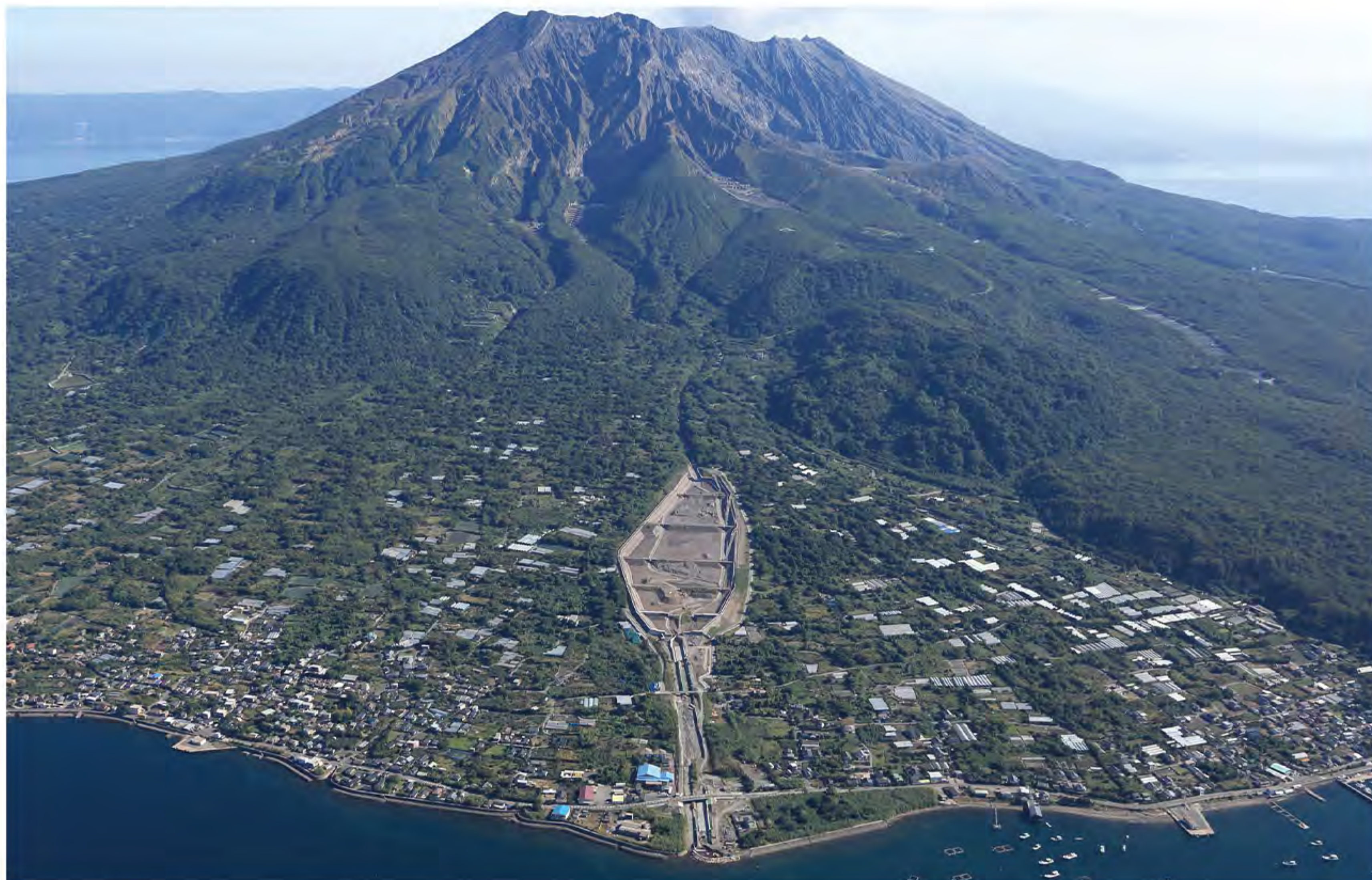
Área de retardo de arena para escombros volcánicos en Sakyurajima en Japón, diseñada por Nippon Koei (Foto: Río Osumi y Oficina Nacional de Carreteras, Ministerio de Tierras, Infraestructura, Transporte y Turismo)
