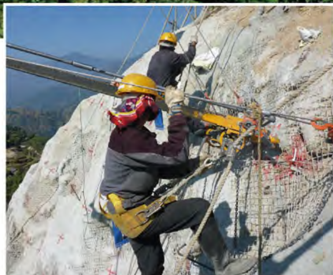
Perforación de rocas
