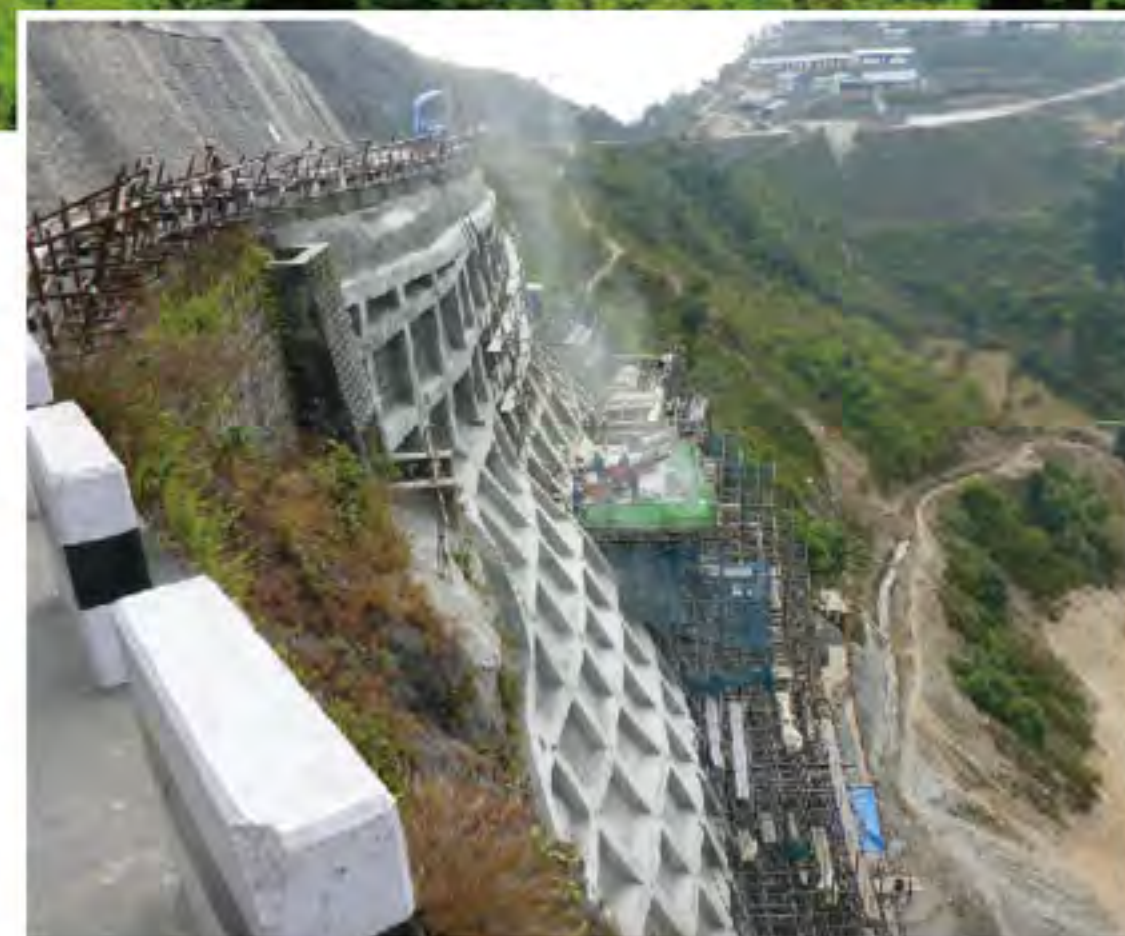
Obras de anclaje
