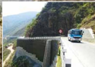
第3工区スコンシ川沿いの急峻な斜面に設けた補強盛土擁壁
