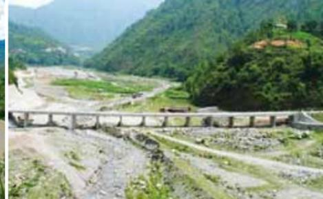
第3工区アンデリ川の扇状地に完成したボックス型コースウェイ
