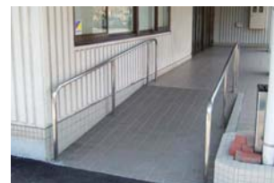
正面玄関に設置したスロープと手すり
