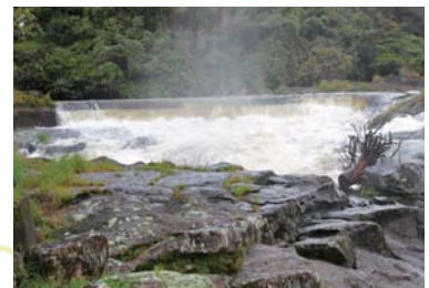
小水力発電所建設地付近の様子
