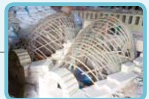
窯を形づくる筋には、乾燥して強度が増した冬の竹を使用。
