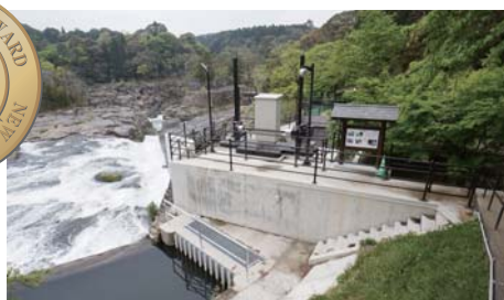
新曾木発電所
