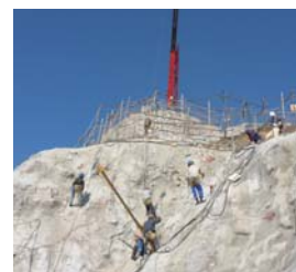
ネパール初のロープワークを駆使した工事
