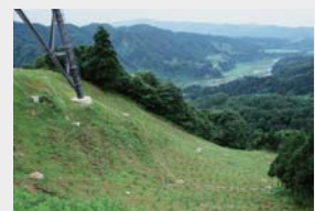
地すべり自動観測システム
