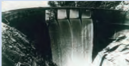
屋久島総合電源開発事業
