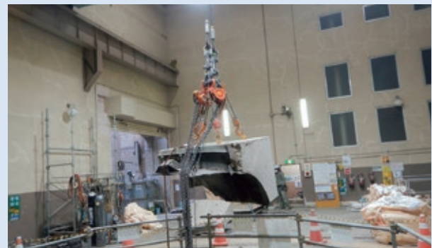
ワイヤーソーによる切断ブロック搬出
