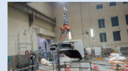
ワイヤーローによる切断ブロック搬出
