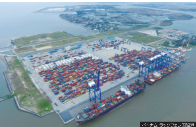
ベトナム ラックフェン国際港
