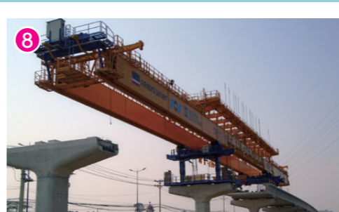
⑧ ベトナム国ホーチミン市 都市鉄道建設プロジェクト (ベンタイン〜スオイティエン間<1号線>) 鉄道 実施期間：2008-2019
