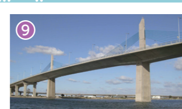
⑨ チュニジア国ラデス ラグレット橋建設事業 橋梁 実施期間：2000-2009 (フィージビリティ調査は1989-1991)
