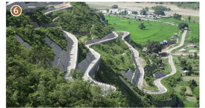
⑥ ネパール国シンズリ道路建設計画 道路 実施期間：1986-2015
