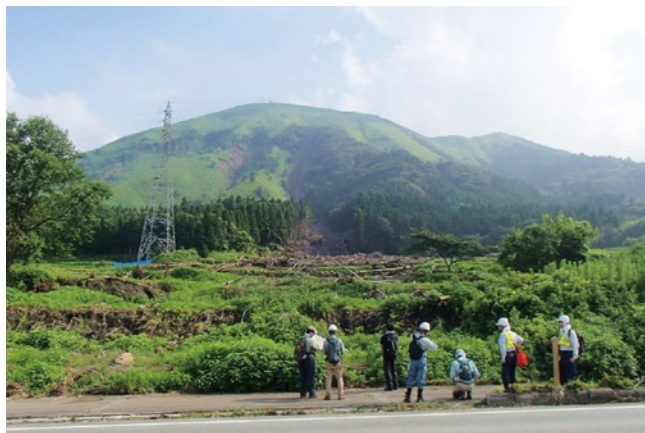
土砂災害箇所の現地調査（熊本県南阿蘇村）
