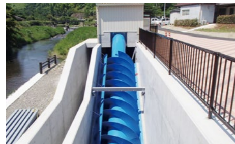
鹿児島県薩摩川内市と共同で実証試験中の「らせん水車」(低落差、小流量での水力発電事業が可能)
