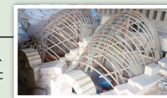
窯を形づくる筋には、乾燥して強度が増した冬の竹を使用。
