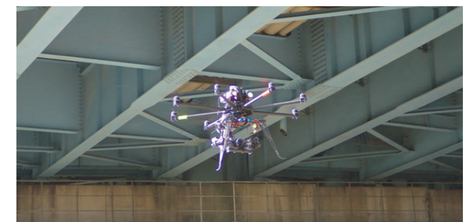
無人ヘリコプターを用いた構造物点検状況
