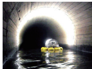
無人水路トンネル計測システムの適用状況
