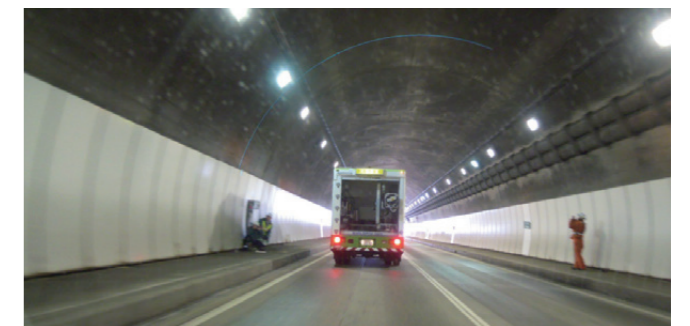
道路トンネルレーザーシステムの計測状況
