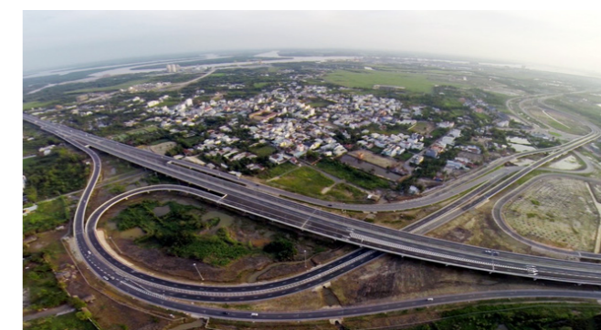
環状2号線とのインターチェンジ(ベトナム高速道路公社:VEC 提供)
