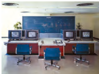
1975（昭和50）年に納入した 変電所集中監視制御システム第一号機
