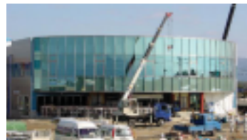
新工場建設の様子
