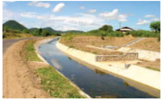
ダムから農地へ導入する幹線水路。
