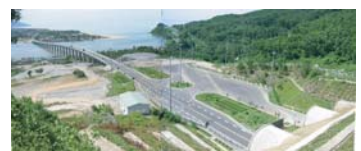
〈トンネル北側からの全景〉
