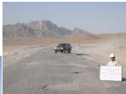
〈事業対象地域の状況/工事前〉
