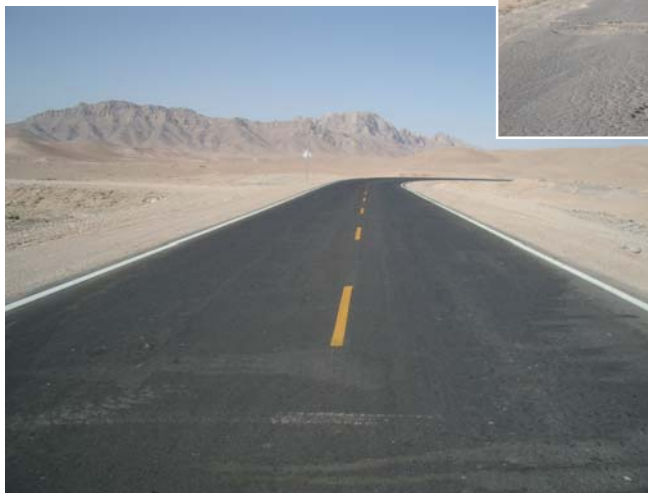
〈事業対象地域の状況/工事後〉
