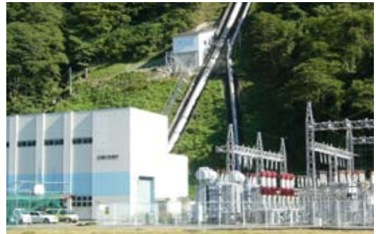
写真の上部にあるのが第三発電所です。発電に用いた水は写真下部の第一発電所で再利用されます。
