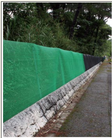
設置したクイナフェンスの外観
