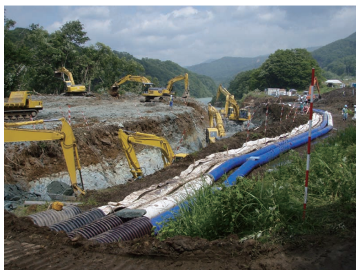
天然ダムの応急対策状況
