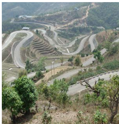
完成した第二工区
