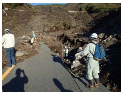
大島町土石流災害時の町道災害復旧のための調査
