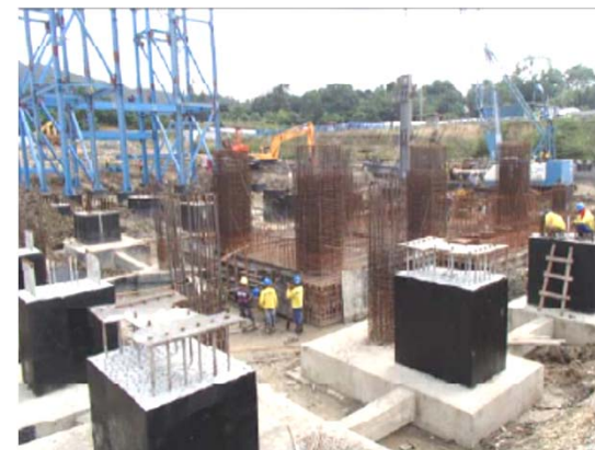
タービン・発電機建屋基礎
