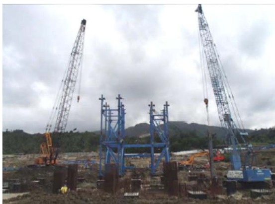
ボイラー鉄骨の組立
