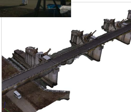
UAVによって測量、 3Dモデル化した 大河津可動堰
