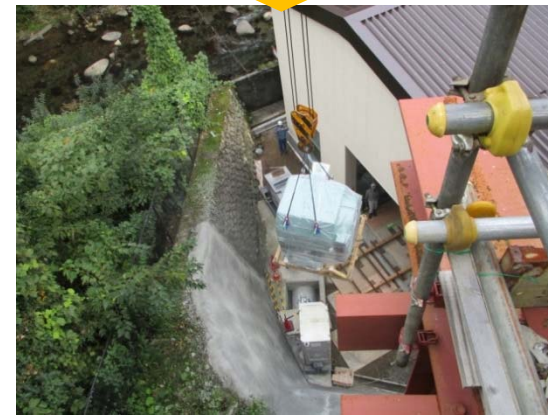
機器(重量物)搬入状況
