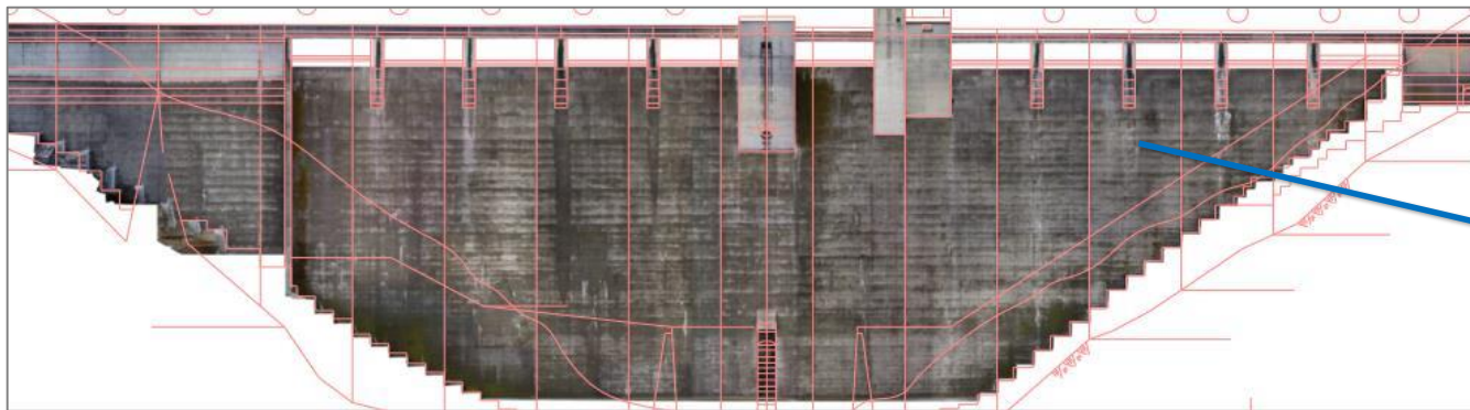
ダム堤体をドローン（無人航空機）で撮影し、亀裂を抽出
