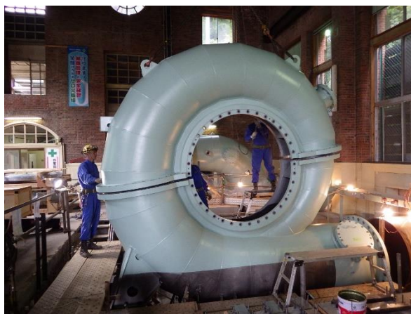
水車組立状況
