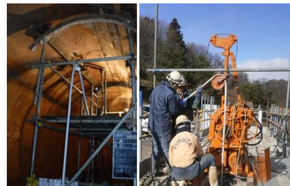
発電所水路上部保全工事(VE提案)
