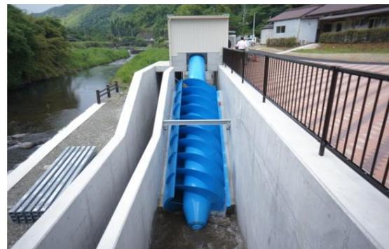
※写真は実証実験中の小鷹水力発電所（小鷹井堰地点らせん水車導入実証設備）
