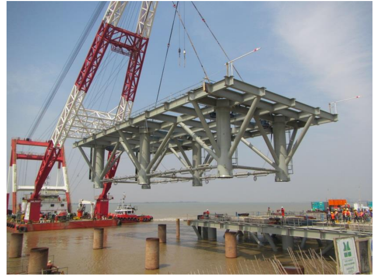
ジャケット(250t)据付
