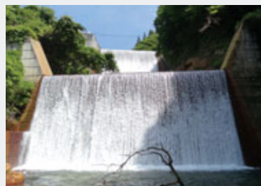
高井発電所（長野県 高山村）
