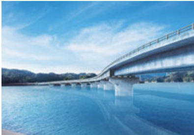
伊万里港(七ツ島地区)臨港道路 (九州地方整備局 港湾空港部 2014年設計)
