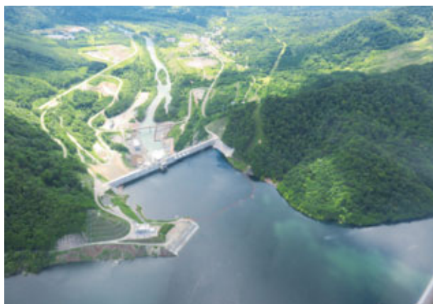
タ張シューパロダム (北海道開発局 札幌開発建設部 2014年完成)
