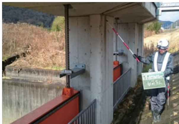
河川構造物の点検実施状況 (近畿地方整備局 姫路河川国道事務所2015～2017年調査実施)
