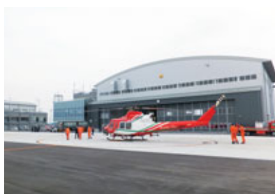
宮城県防災ヘリコプター管理事務所・ 仙台市消防航空隊庁舎及び格納庫(2018年竣工)
