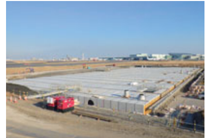
東京国際空港地下式貯留施設 (関東地方整備局 東京空港整備事務所 2014年設計)
