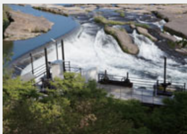
新曽木発電所（鹿児島県 伊佐市）
