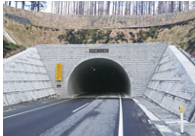
一般国道340号立丸峠地区道路詳細設計業務委託 (岩手県沿岸広域振興局 2017年完成)
