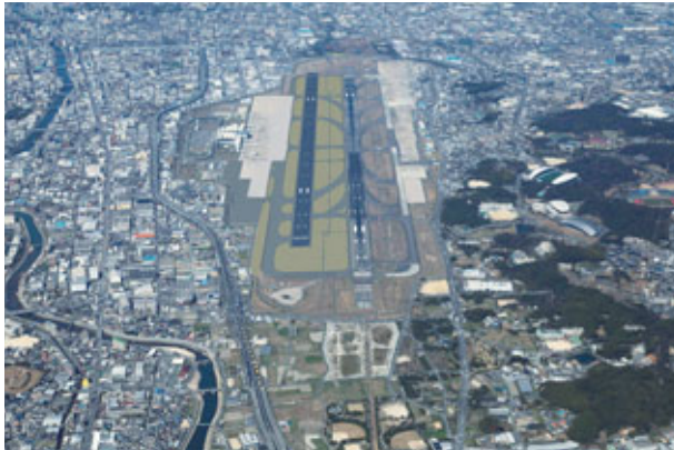
福岡空港滑走路増設事業 (九州地方整備局 博多港湾・空港整備事務所 2013年設計)
