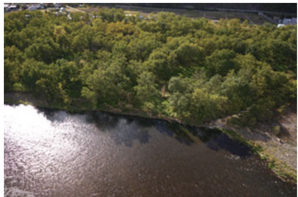
河道内樹木繁茂状況
