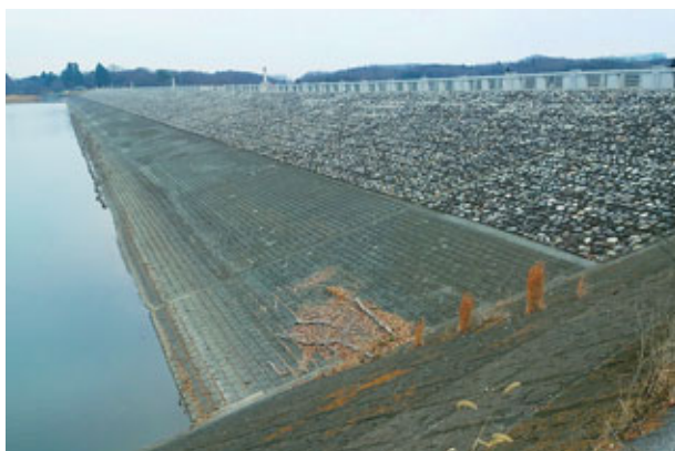
山口貯水池 (東京都水道局 2002年完成)
