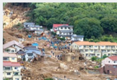
2014年 広島豪雨災害 (中国地方整備局 太田川河川事務所)
