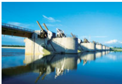
大河津可動堰 (北陸地方整備局 信濃川河川事務所 2011年完成)
