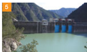
5 宮川ダム (三重県 2005年度竣工)
