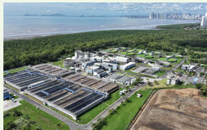
パナマシティ廃水処理プラント
