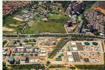
アグアス・クララス下水処理場
