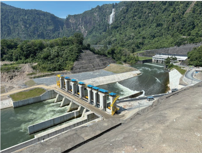
インドネシア アサハン第三水力発電所外観
